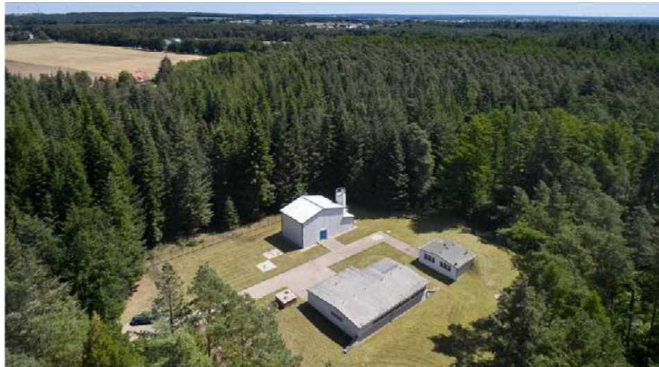
Nitratintrusion in den Grundwasserleiter bei Nienburg
